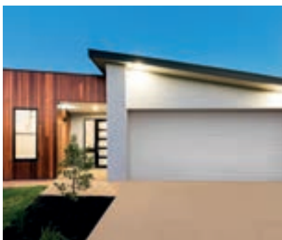
Habitations préfabriquées en béton Fertighäuser aus Beton
