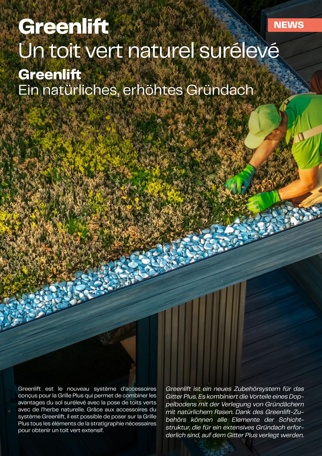
Greenlift est le nouveau système d'accessoires conçus pour la Grille Plus qui permet de combiner les avantages du sol surélevé avec la pose de toits verts avec de l'herbe naturelle. Grâce aux accessoires du système Greenlift, il est possible de poser sur la Grille Plus tous les éléments de la stratigraphie nécessaires pour obtenir un toit vert extensif.
